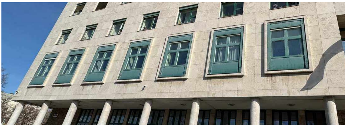
2. kép 7db meglévő 70-es évekbeli fa parapetes ablakok kőkeretben (Fáy2025)
