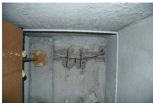
A közbenső gerendán sok betonacél probléma jelentkezett.
