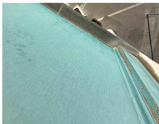
3. kép utólagos szárnyduplikálással javított ablakkeret (Fáy 2025) és külső-belső részletek
