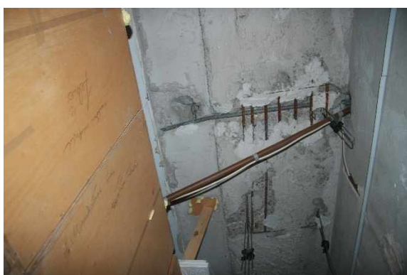
A közbenső gerendán sok betonacél probléma jelentkezett.
