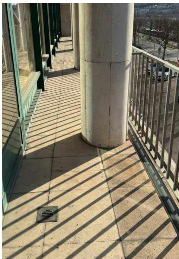
10. kép Első két összefolyóból csak a kijárat előtti működik (Fáy2025)
