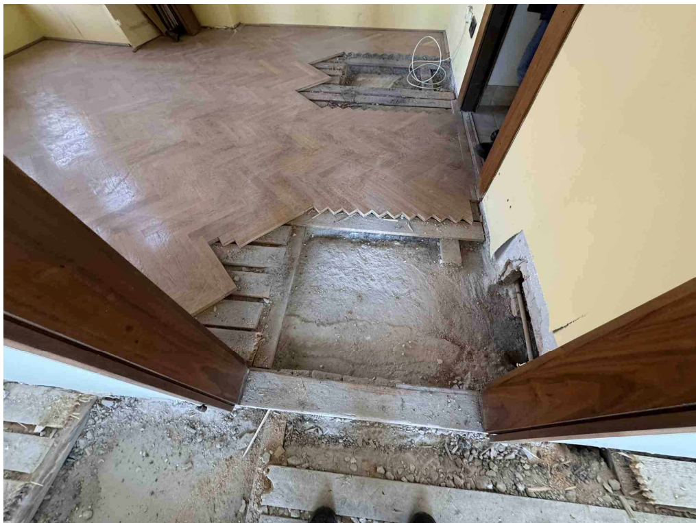
20. kép feltárások a két traktus határán az északi helyiségekben
