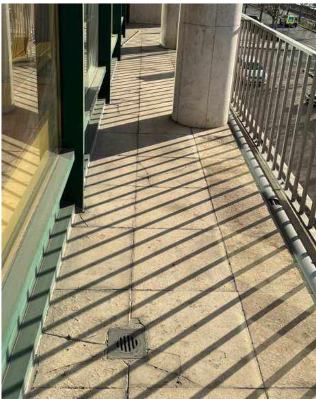
12. kép harmadik összefolyó körül törött burkolat, javítás nyomai, az elfolyás bizonytalan (Fáy 2025)
