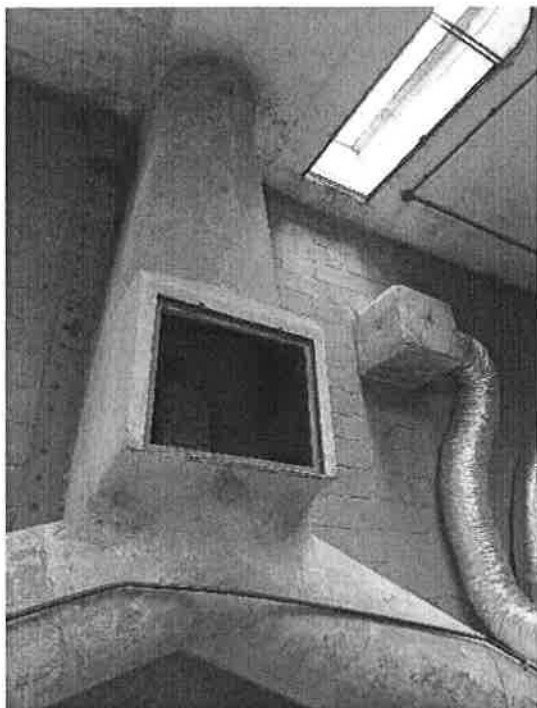
Gravitációs szellőzés szerviz nyílása és pillangószelepe
