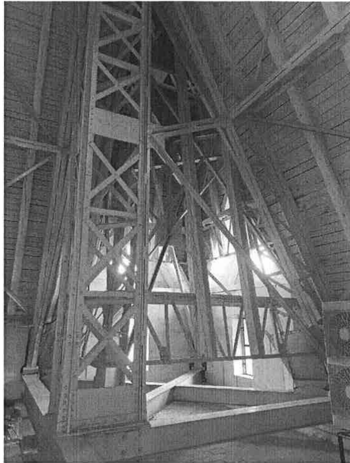
Főemelet 11. feletti padlástér tornyainak acélszerkezete
