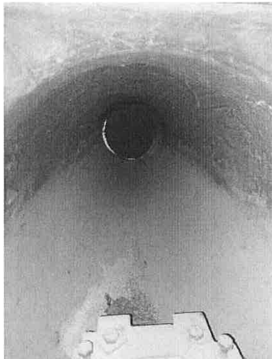
Gravitációs szellőzés szerviz nyílása és pillangószelepe
