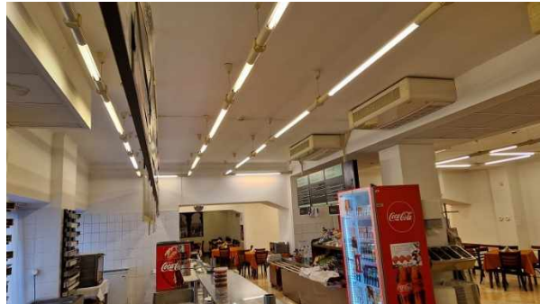
Lapradiátor és mennyezeti fan-coil-ok
