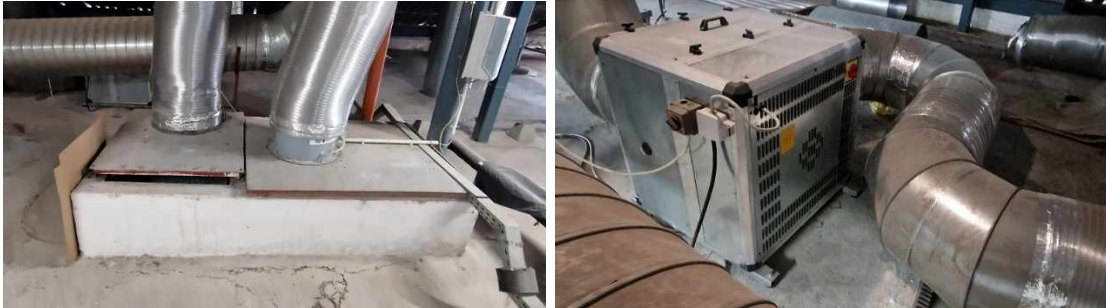
Padlástéri légcsatornák, elbontandó konyha elszívó ventilátor
