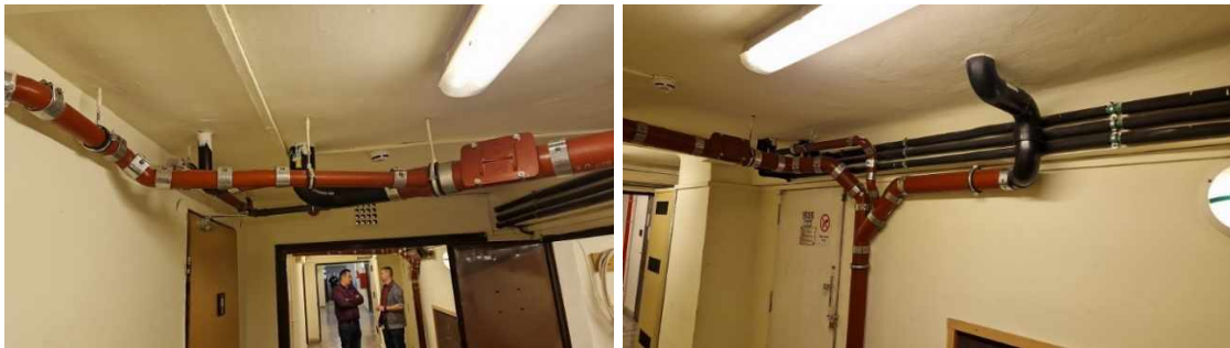
A földszint mennyezetén lévő csatorna elhúzások, csatlakozási lehetőségek
