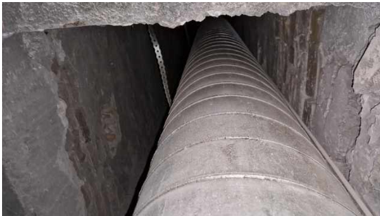
Ø450mm átmérőjű spiko elszívó légcsatorna az aknában
