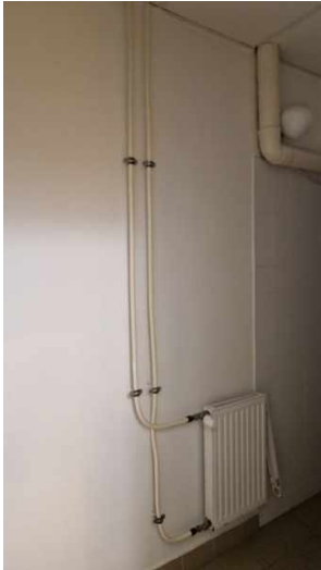
Lapradiátor és mennyezeti fan-coil-ok
